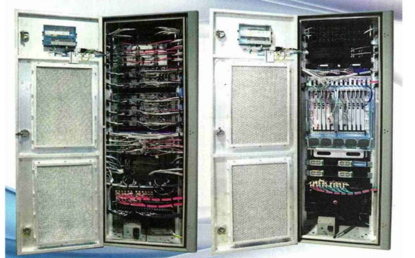
Elsel nasce come azienda specializzata nella progettazione (e poi anche realizzazione) di schede elettroniche. Nell'immagine 2 rack: a sinistra il Rack Management MFC e a destra il Rack Data Center CMS, sviluppati per "Legge Navale".
